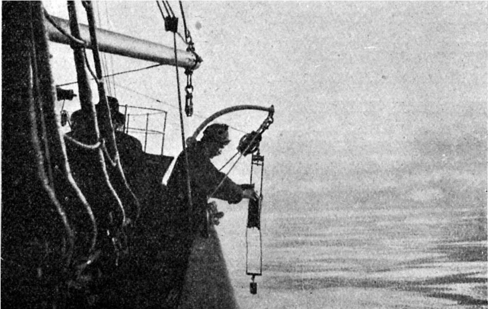
***Батометръ подняли и вставляютъ въ него термометръ.***
